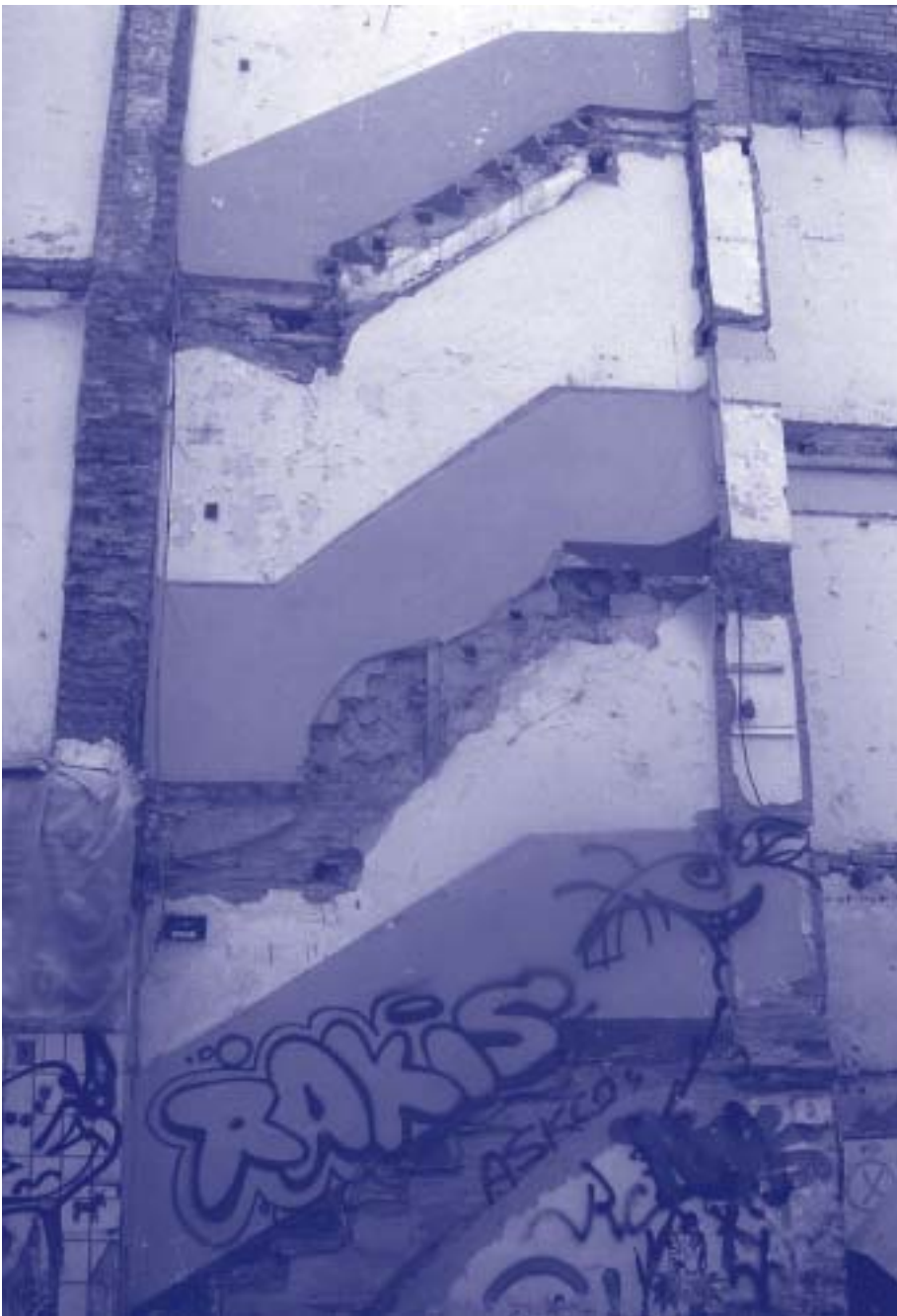
Mar Martín, Deconstrucción 2 .
